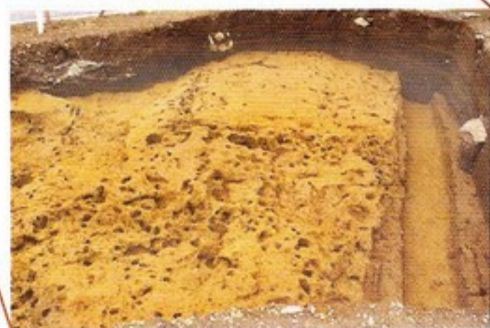
セザール巣鴨地区の葎簀圀と側溝
